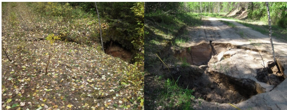
Рисунок 4.1-6 Просадка на дороге в логу Голубинском (слева); сложная строенная провальная форма на дороге на Войван (справа)
